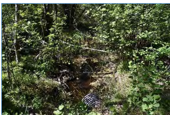
Bild nr 54: Rasat galler i utloppet från Stora Djäkna sjön.
