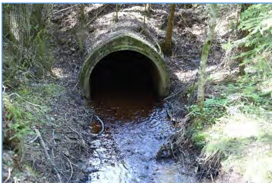
Bild nr 21: Sträcka 13. Vägtrumma som är fylld med grus till en tredjedel.
