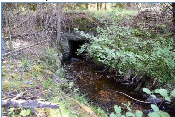
Bild nr 22: Sträcka 14. Bron över bäcken där sträckan börjar.
