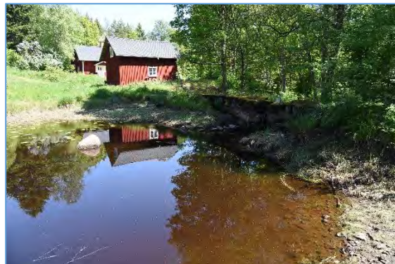
Bild nr 23: Sträcka nr 4. Dammen vid Sågdammen. Mycket lågt vattenstånd vid inventerings-tillfället.
