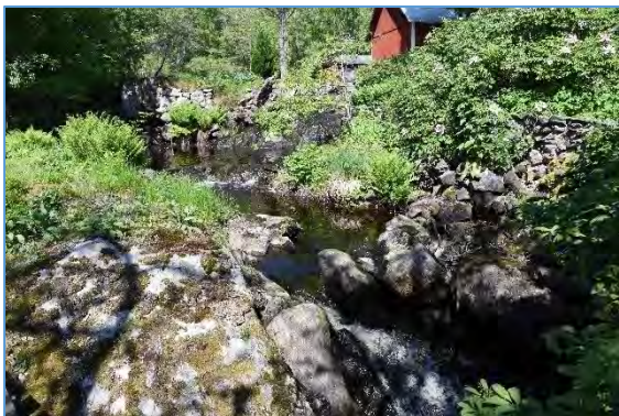
Bild nr 16: Sträcka nr 3. Dammen från nedströmssidan.
