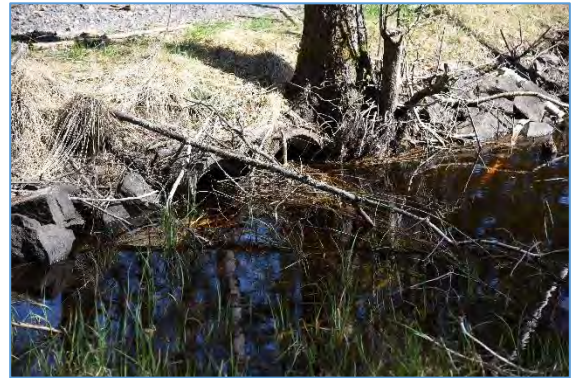
Bild nr 65: Betongtrummorna mellan Stora- och Lilla Tingsjön.
